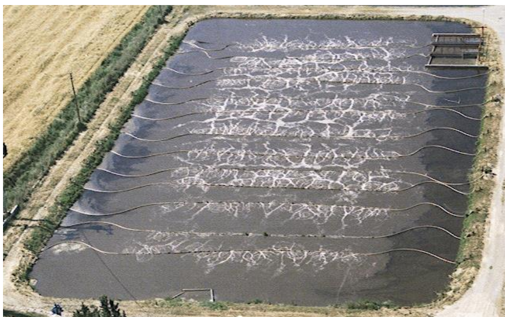
Vista aèria de la primera llacuna de la depuradora de Cervera
